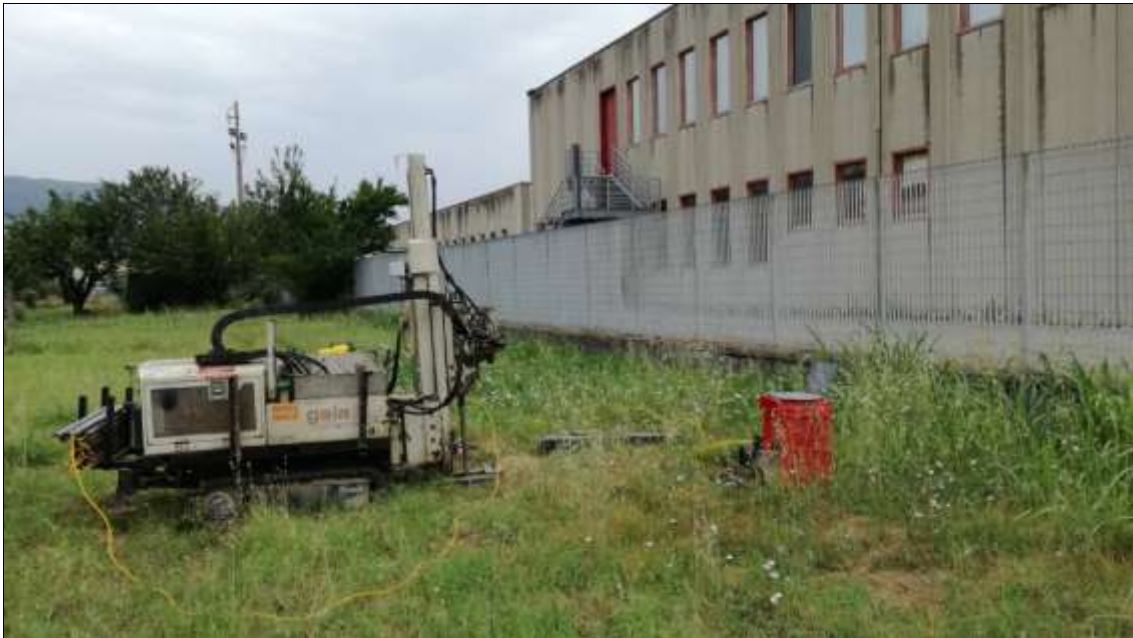
Figura 10.3. Esecuzione prova CPTU 2
