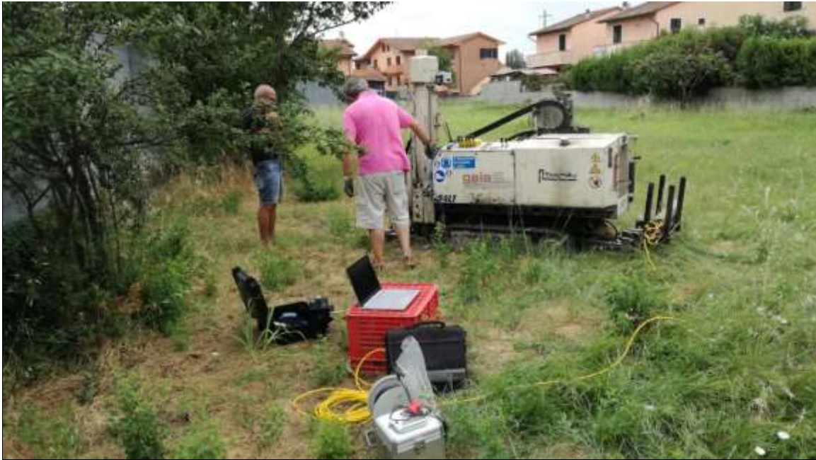
Figura 10.2. Esecuzione prova CPTU 1
