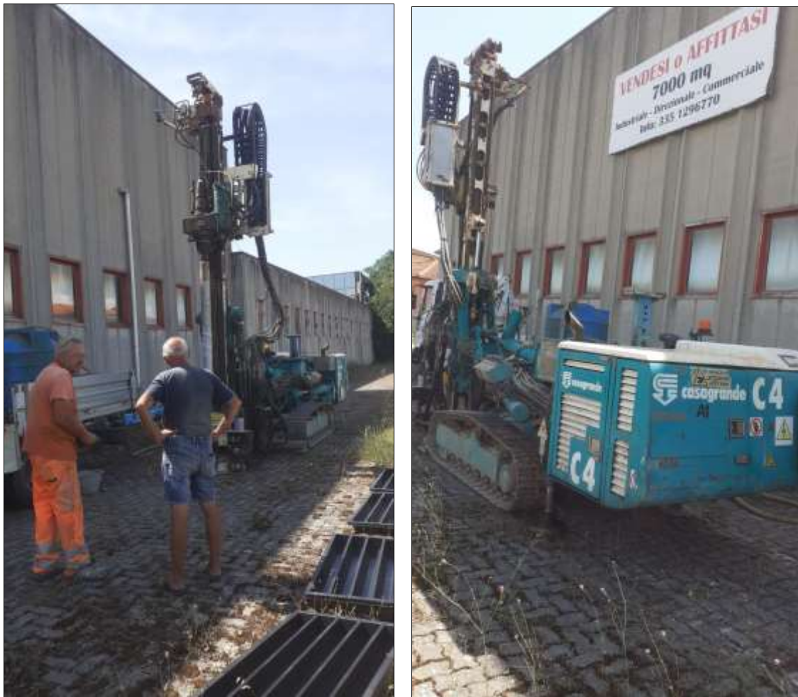
Figura 10.1. Esecuzione sondaggio S1
