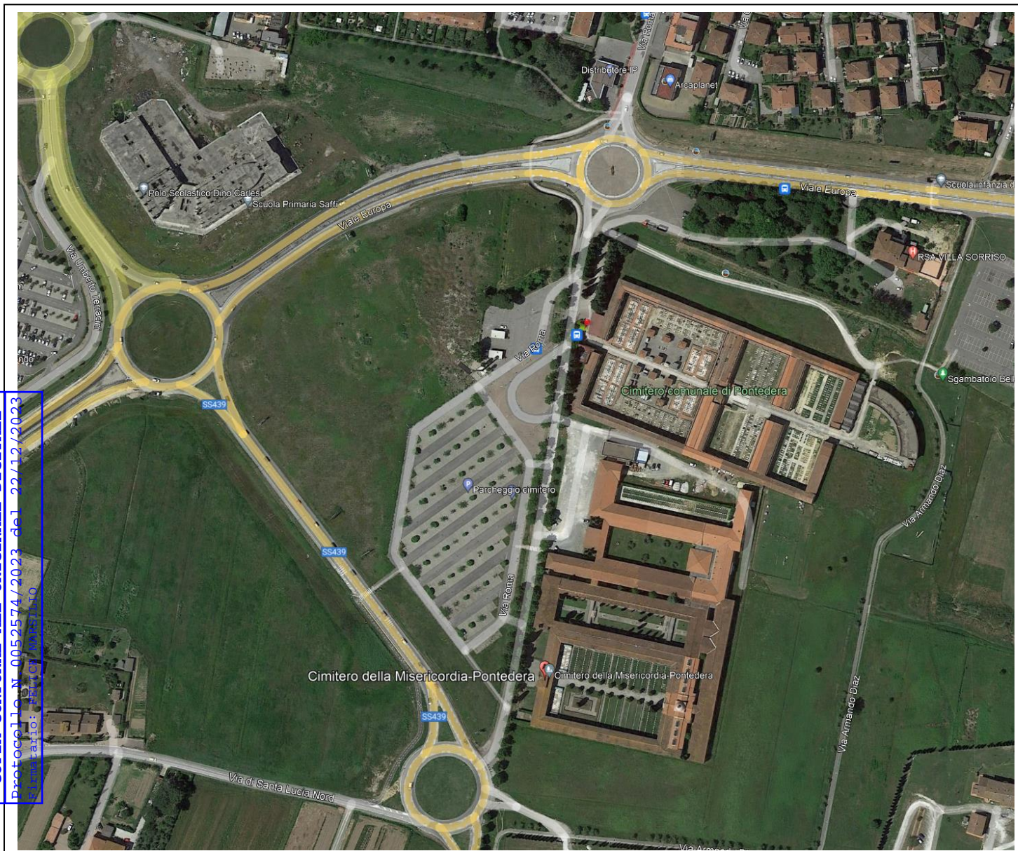
FIG. 1.1 VEDUTA AEREA DELLA ZONA E DELL'AREA DI INTERVENTO
